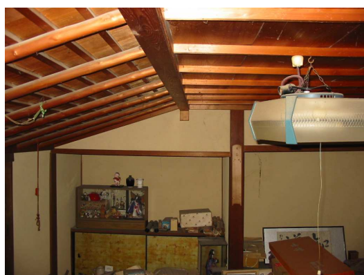
2階南の西の和室の西面
