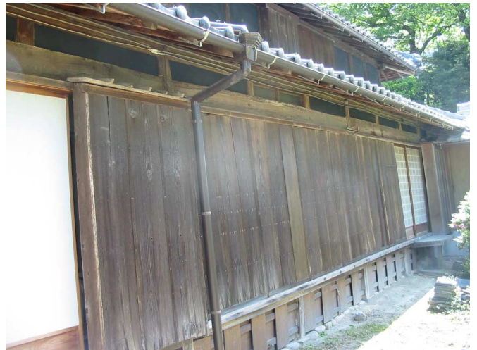
北面 1 階の雨戸と開口
