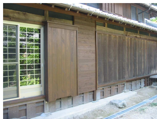
北面雨戸改修
