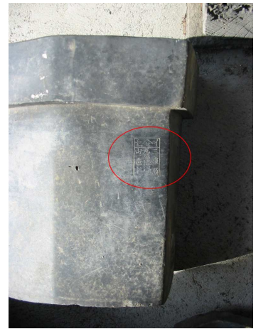
既設瓦(駒形冠瓦)と刻印
