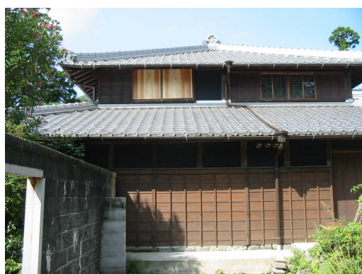
東面全景 瓦全面葺替え
