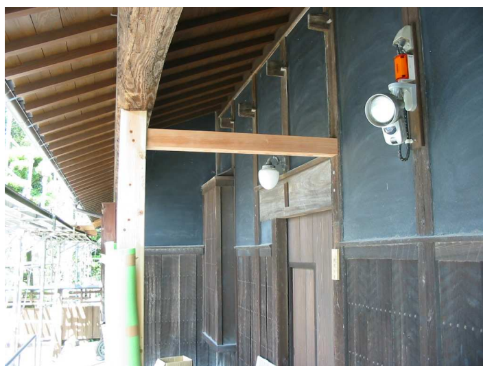
玄関ポーチの柱新設部分
