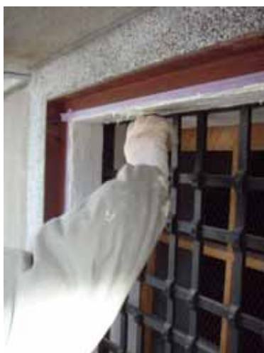
窓枠廻りの漆喰塗 補修
