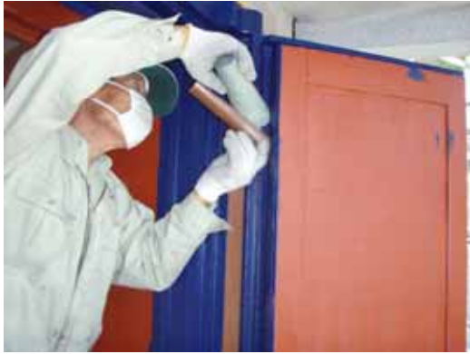
東面の金庫扉 抜けた砂を内部に 再注入
