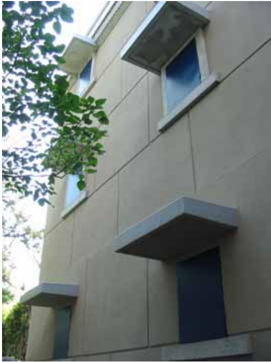
北面全景 下地処理後 薄付材吹付
