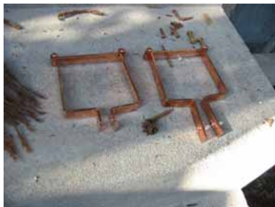
縦樋の掴み金物 銅製で既設に倣 って作成
