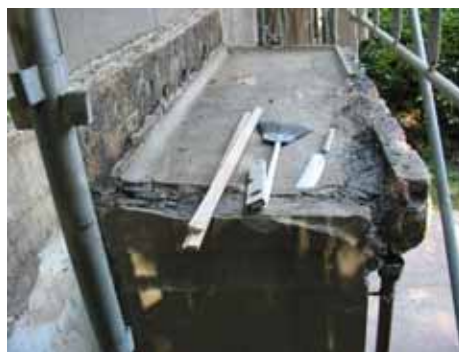
庇カドのドレン金物(左) 庇の全景(右)
