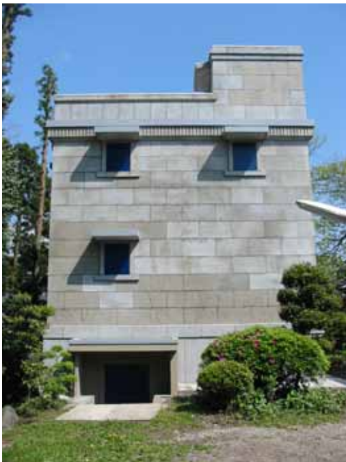
南面全景 補修箇所と既設 部分の色違いが 分る
