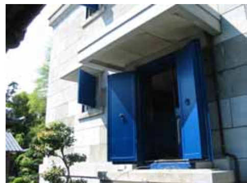
東面の金庫扉 錆止め処理後 再塗装し可動 調整
