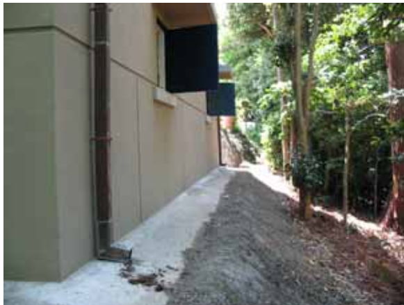
西面犬走り 土羽は盛土に よる地盤改良
