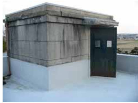
屋上 PH 部分
