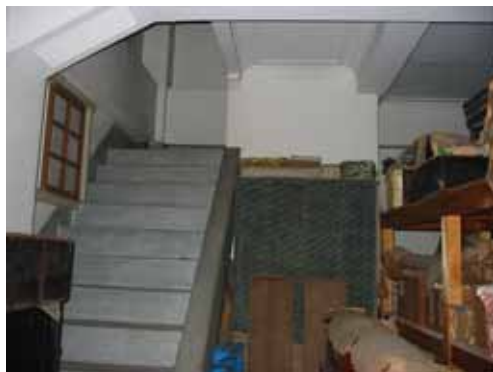
内部階段 廻り
