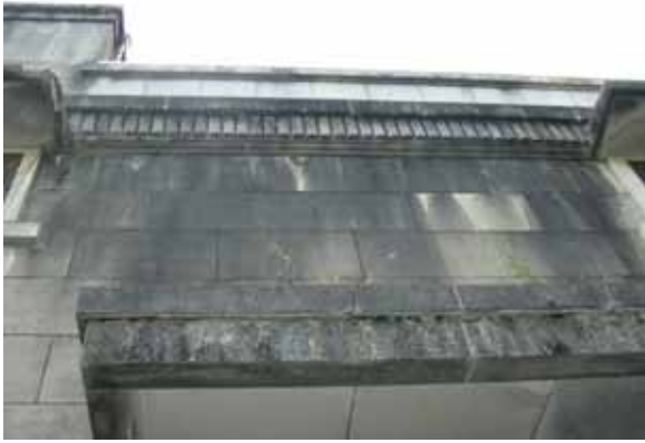
東面上部の壁の状態
