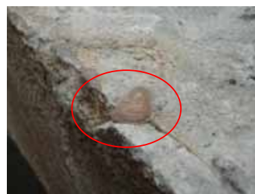
窓庇のコンクリートに 混じる貝殻
