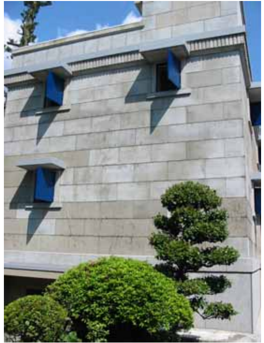
南面外壁 モルタル刷毛引後 撥水剤塗布
