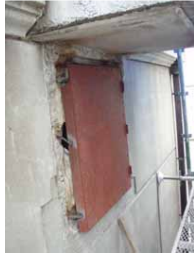
3階北面窓 枠共新設する
