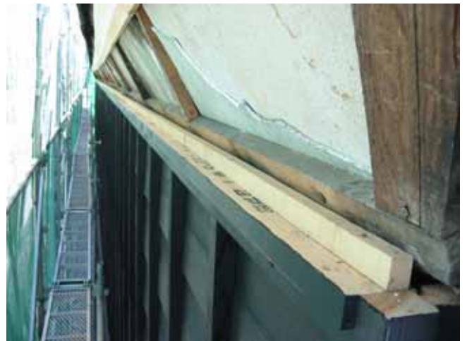
鉢巻部の下地取付前
