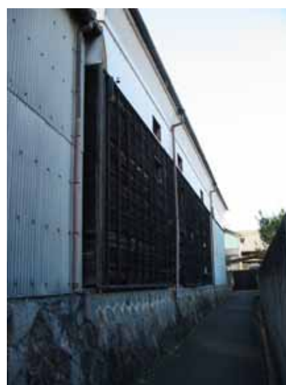
一号二号倉庫 東面全景と小道
