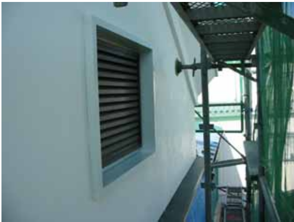
北面ガラリ部の漆喰塗壁補修
