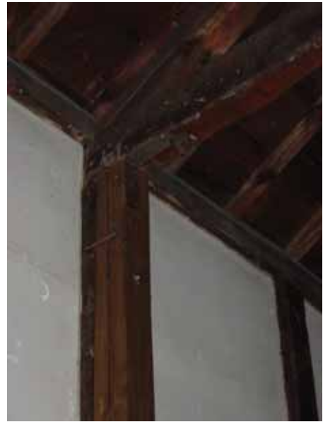
柱の補強補修（添え柱）
