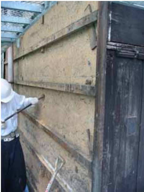
トタン壁解体後 木下地取付用金物 取付
