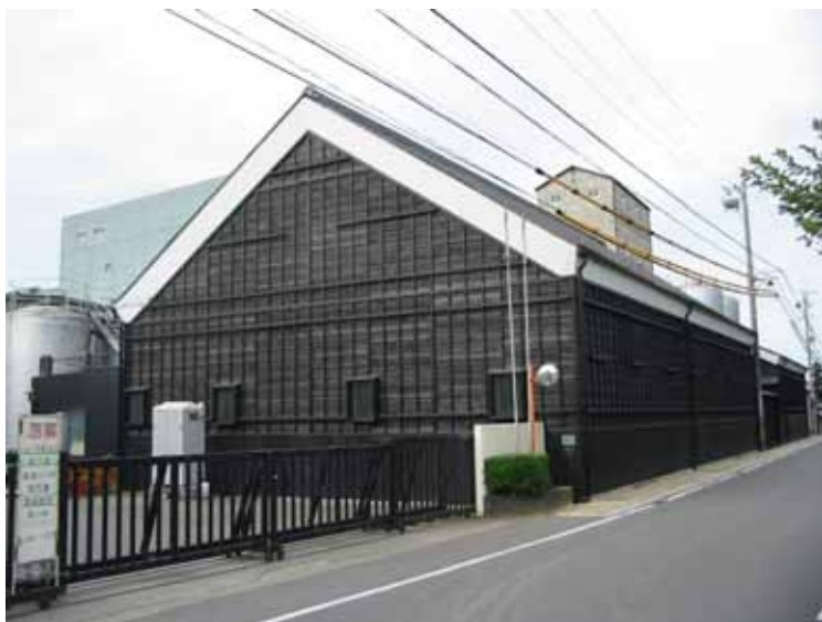
足場解体後の 全景
