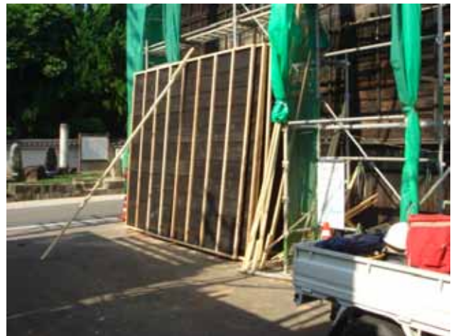
下見板取付の様子
