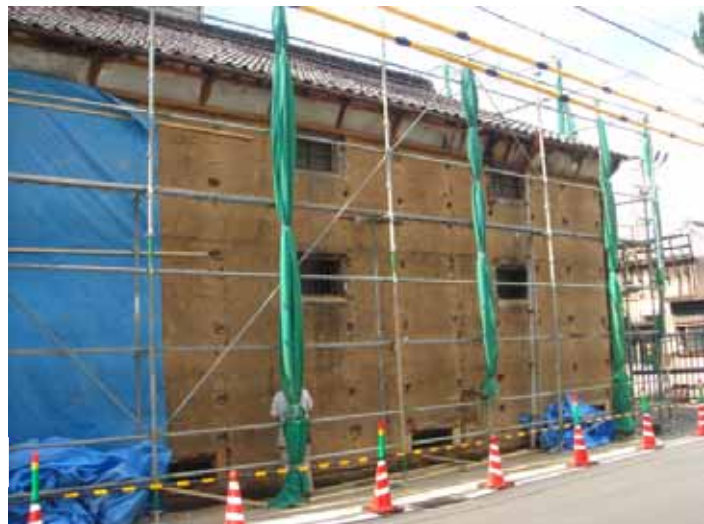
壁木下地取付前の様子
