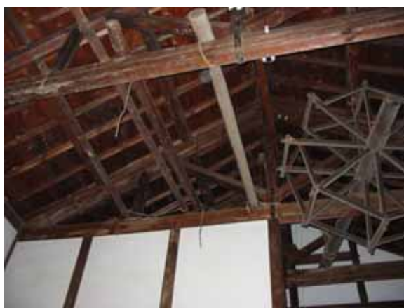
一号倉庫内部の 小屋組
