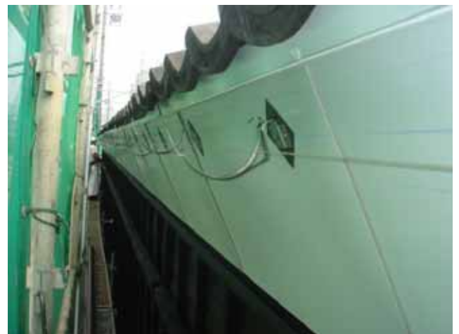
鉢巻部の鋼板取付後
