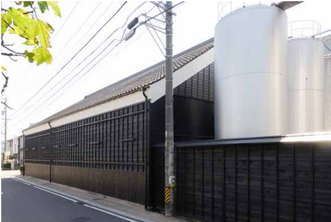
本蔵北面と塀の外壁
