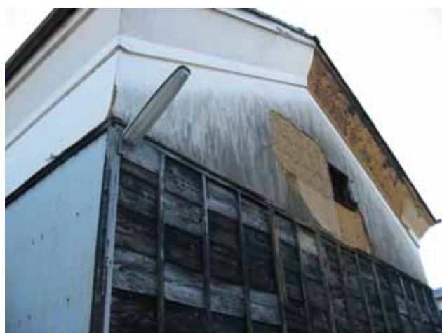
一号二号倉庫 北面上部
