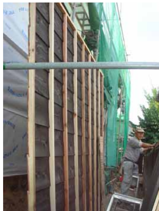
下見板取付の様子
