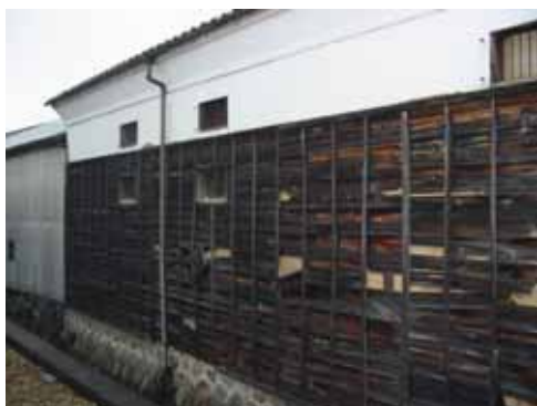
一号二号倉庫 東面全景
