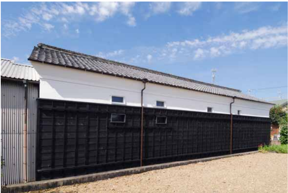
一号・二号倉庫 東面全景
