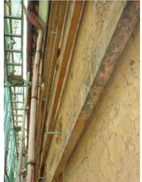
トタン壁解体後 木下地取付用金物 取付
