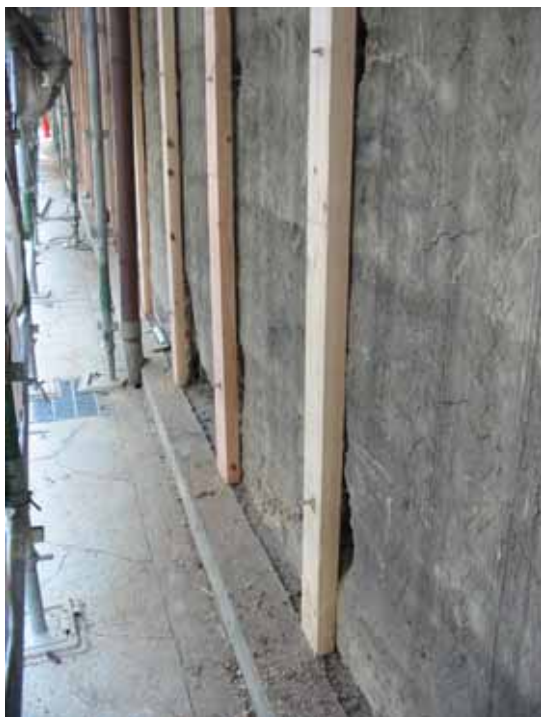
北面下見板取付用木下地
