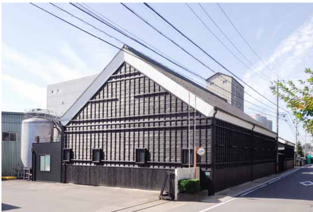
本蔵北東よりの全景
