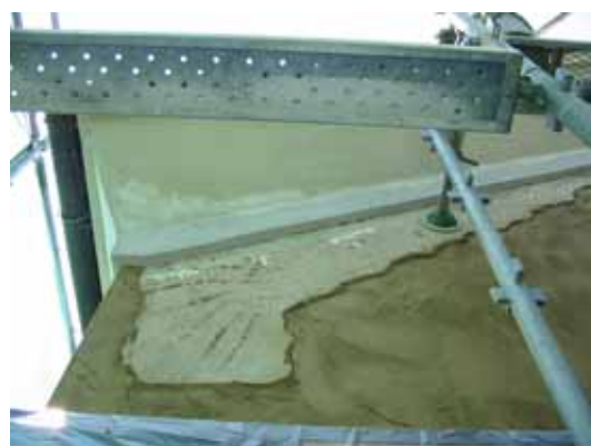
北面漆喰塗の補修
