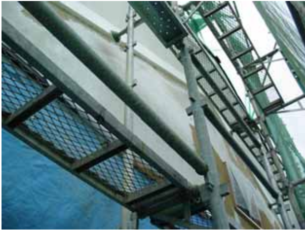
北面漆喰塗壁の補修状況
