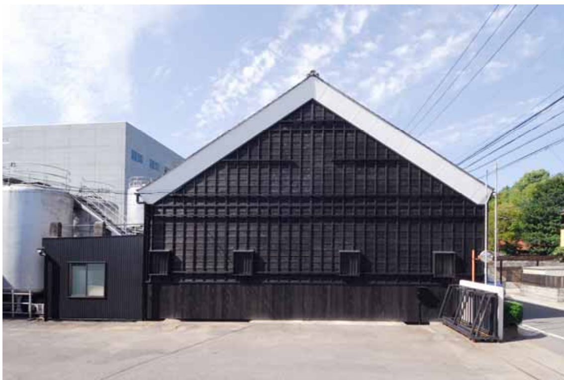
本蔵東面の全景
