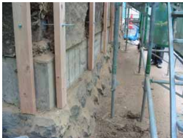
北面下見板取付用下地の下部
