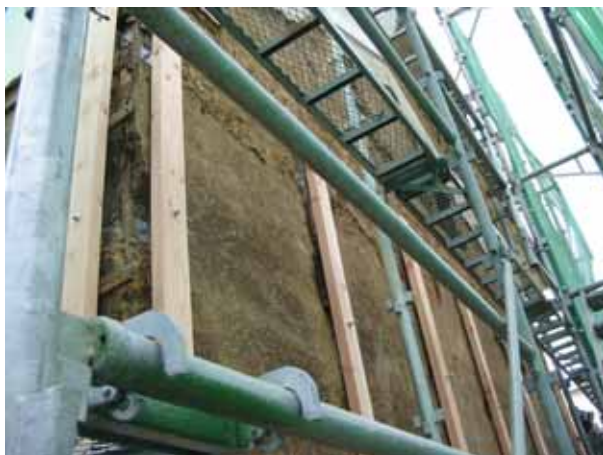
北面の下見板取付用下地
