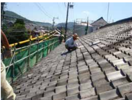
屋根瓦の補修の様子
