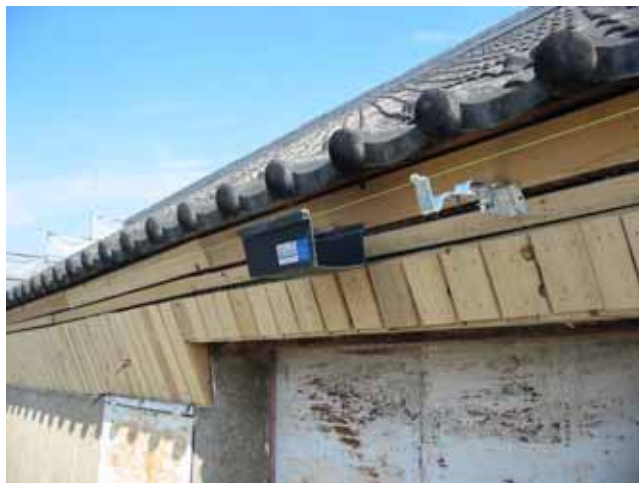
南面鉢巻部分のザラ板
