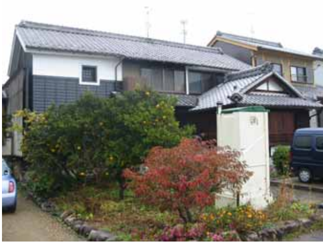
蔵・離れ 完成前の様子
