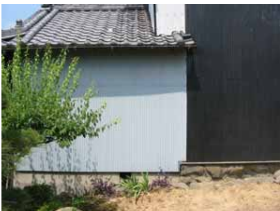
離れ東面 ( 蔵本体との接続部 )
