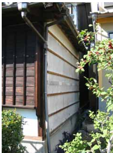
離れ 波トタン撤去後の 東面壁
