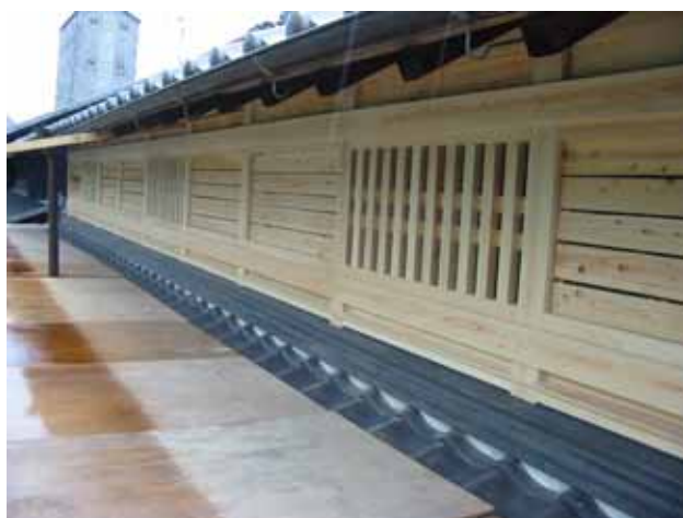
主屋 2階壁木工事完了
