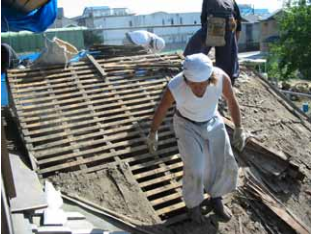
離れ 日本瓦葺（土葺き）撤去
