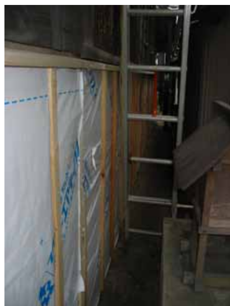
主屋 西面鋼板下地
