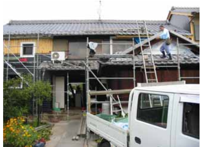
離れ 日本瓦葺きの様子
