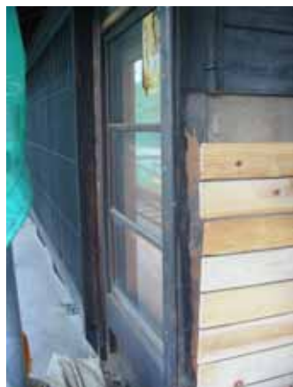
主屋 西カドの壁は硝子戸が現れた
