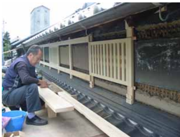
主屋 付柱付梁を取付
