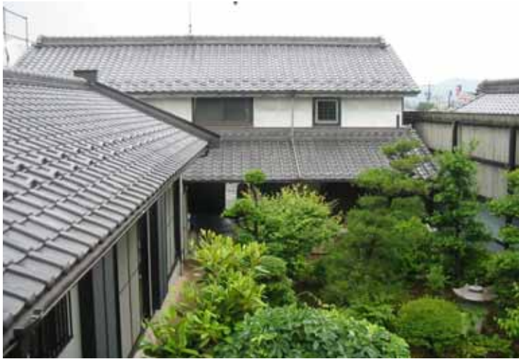
主屋 2 階から中庭越しに 蔵・離れをみる
