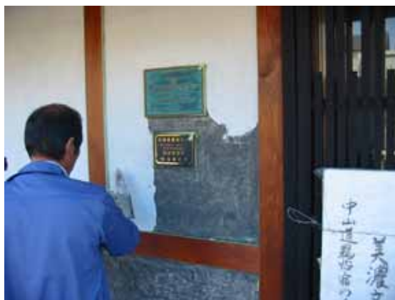
主屋 漆喰壁の中塗の様子
