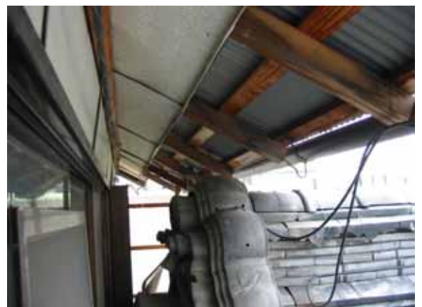
離れ屋根と蔵本体との接続部
