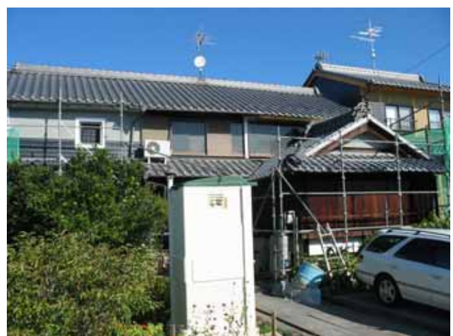
蔵・離れ 屋根瓦葺替え完了
