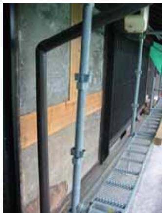
主屋 北面既設壁の様子（損傷はほとんど無い）
