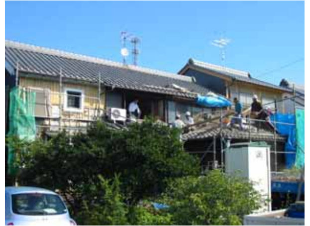
離れ 日本瓦葺撤去の様子
