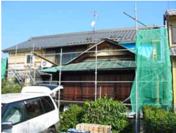
離れ 日本瓦葺き下地
