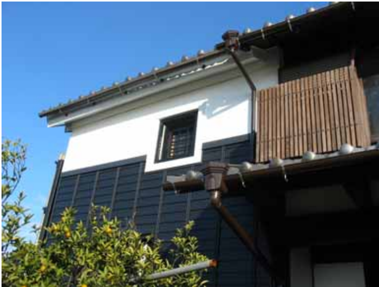
蔵・離れ 南面壁の漆喰塗壁 と目隠し格子
