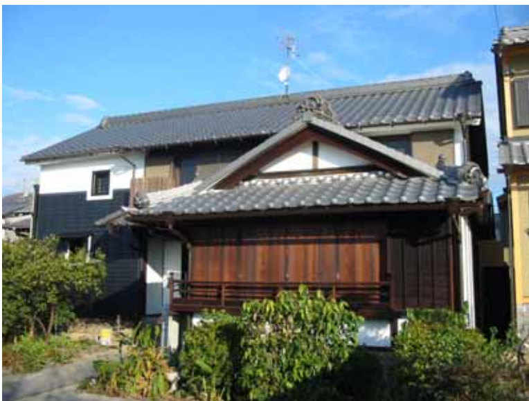
蔵・離れ 完成前の様子
