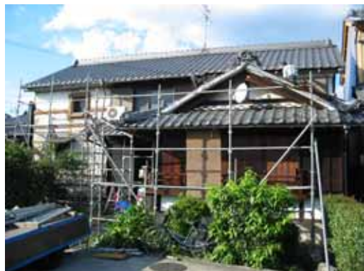
蔵・離れ全景 南側より
