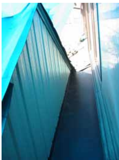
蔵と離れの接合部屋根
