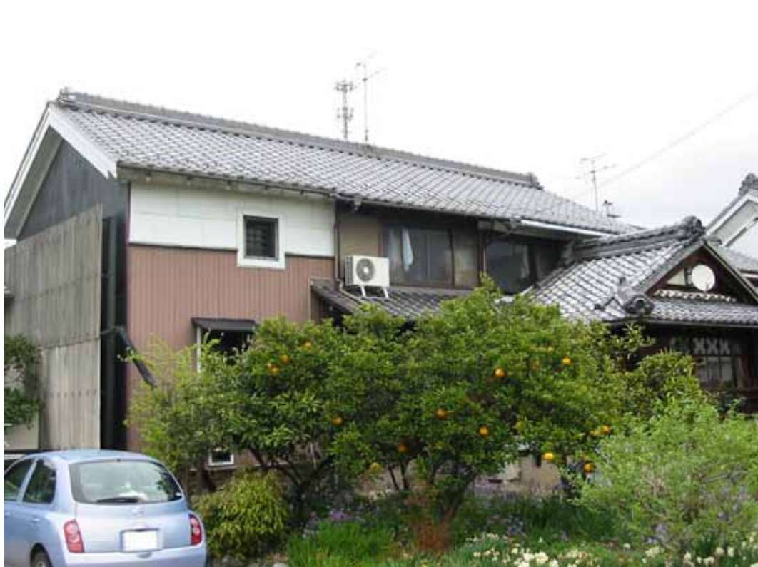
蔵・離れ：南西側よりの全景
