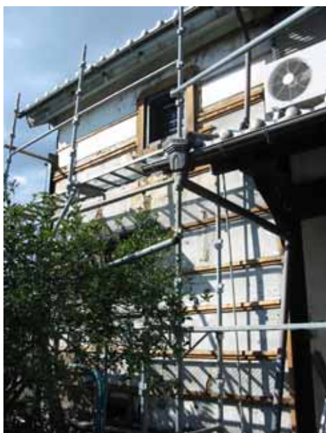
蔵 トタン撤去後の南面壁
