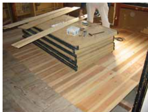
離れ 2階床の根太 補強
