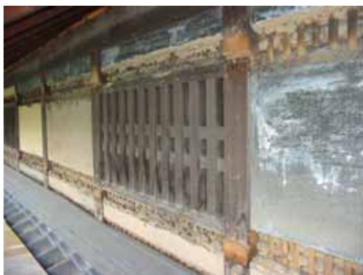
主屋 2階壁の様子 (壁損傷は少ない)
