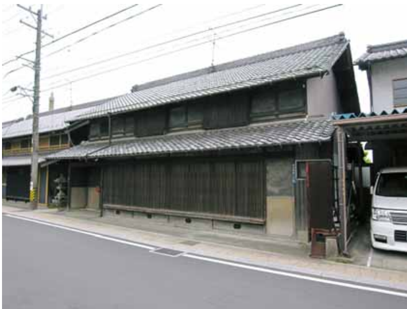
北面・西面の外壁と格子
