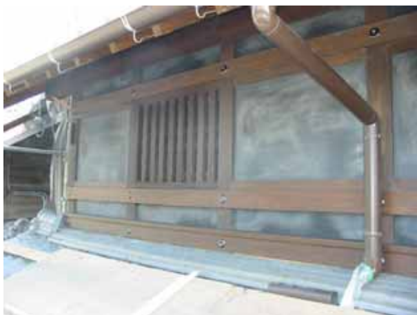
北面 2 階の新設壁下地
