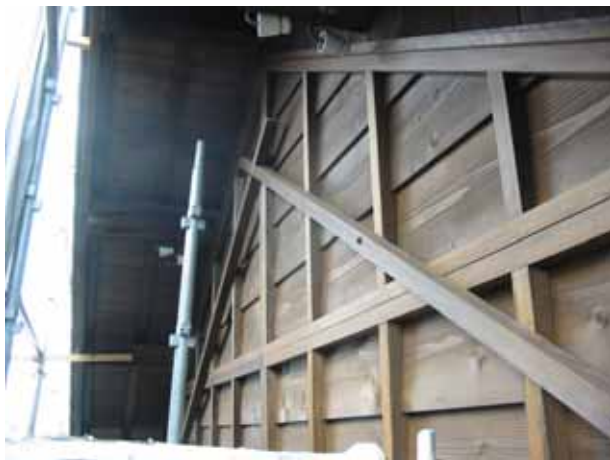
東面下見板の押縁取付
