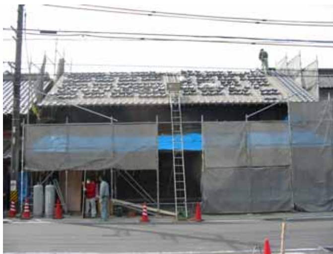
大屋根 瓦葺きの様子
