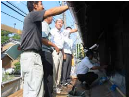
各務原市工事 検査の様子
