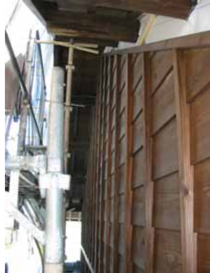
東面の下見板張り
