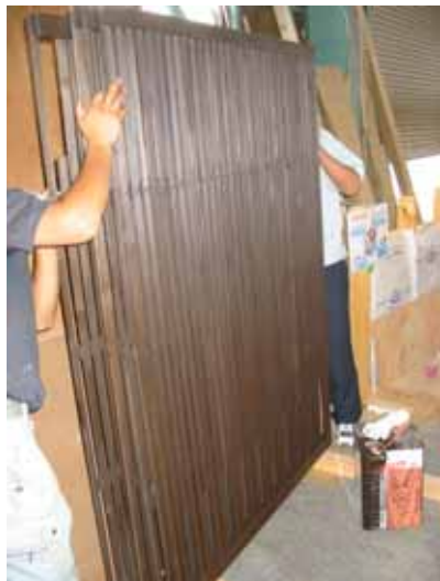
北面格子 作業場で補修
