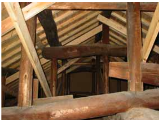
屋根裏小屋補強
