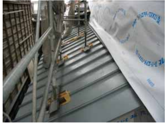
東側下屋の鋼板葺き屋根
