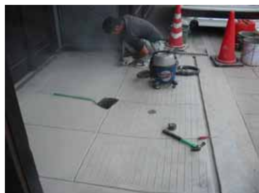
玄関土間の仕上作業
