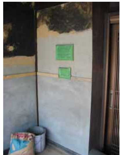
玄関横の壁下地補修
