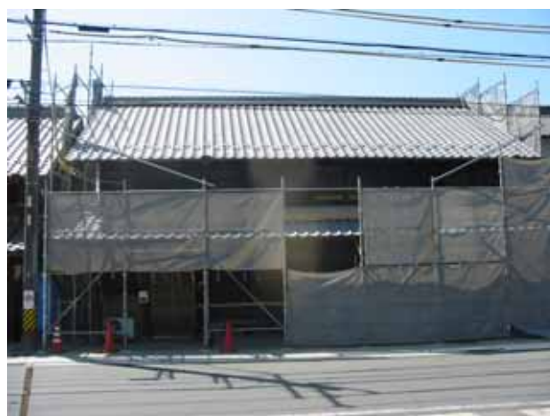
屋根瓦葺き替え完了
