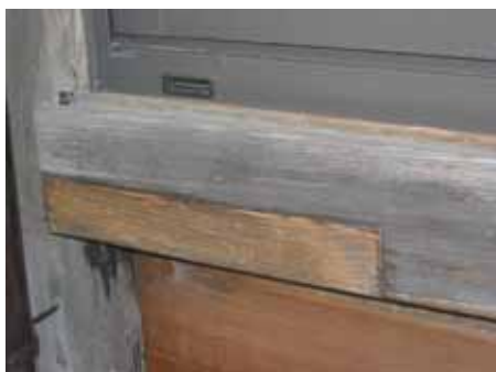
格子敷居の埋木補修
