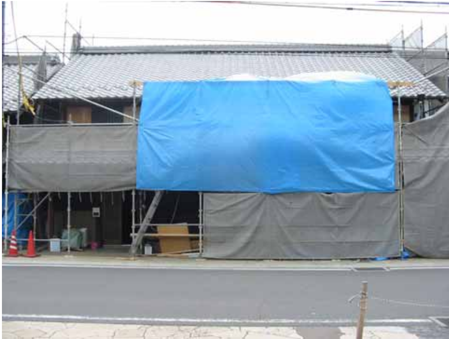
主屋全景 旧中山道より
