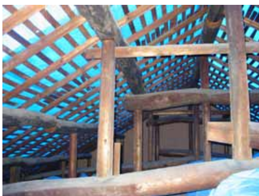
大屋根 既設瓦撤去時の様子
