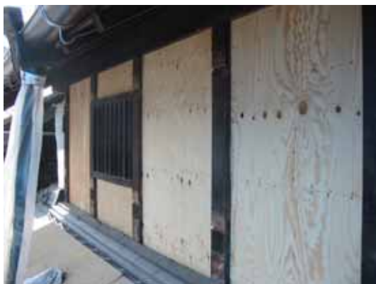
北面 2 階の新設壁下地
