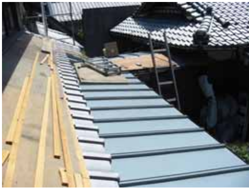
南側下屋の鋼板葺き屋根
