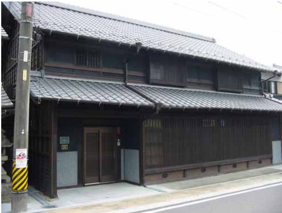
北面・西面外壁と格子
