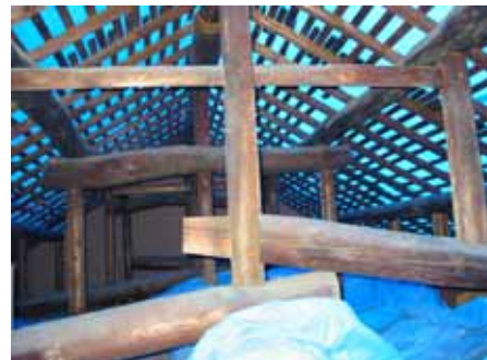
大屋根瓦工事 屋根裏より
