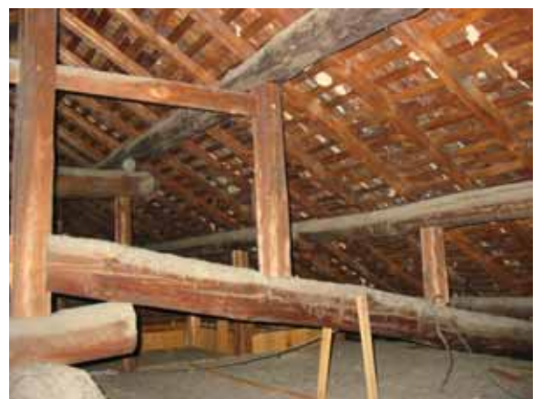
屋根裏の小屋組
